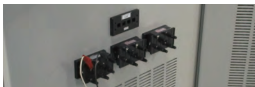
第33図 VTT(電圧テスト端子),CTT(電流テスト端子)
