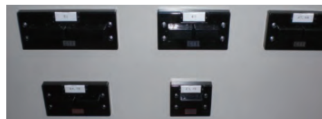
第49図 テスト用端子 (VTT, CTT)
